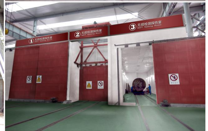
▶ 大型无损检测探伤室 [ 20m×6m×5m ]
